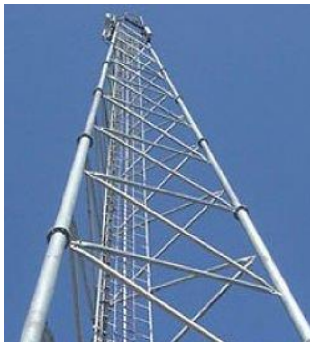
Torre construída com tubos metálicos.
