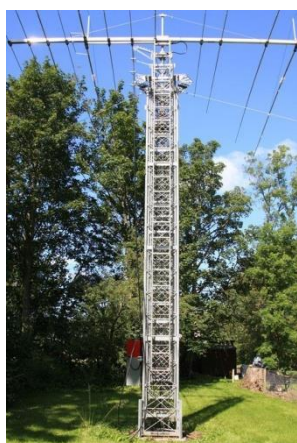
Torre telescópica em posição de ser deslizada
