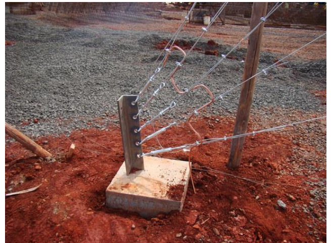
Bloco de ancoragem de 5 estais. Note o aterramento dos estais.
