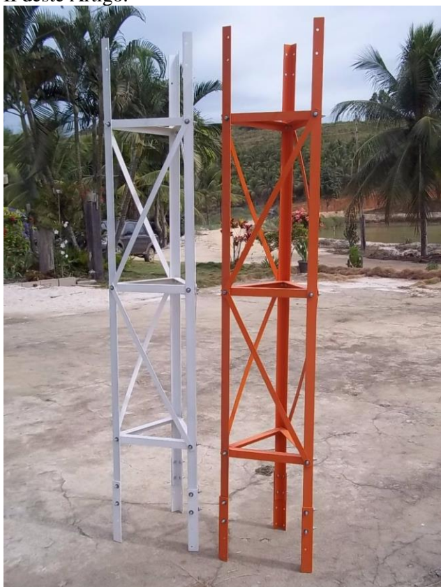
Torre triangular com elementos aparafusados.
