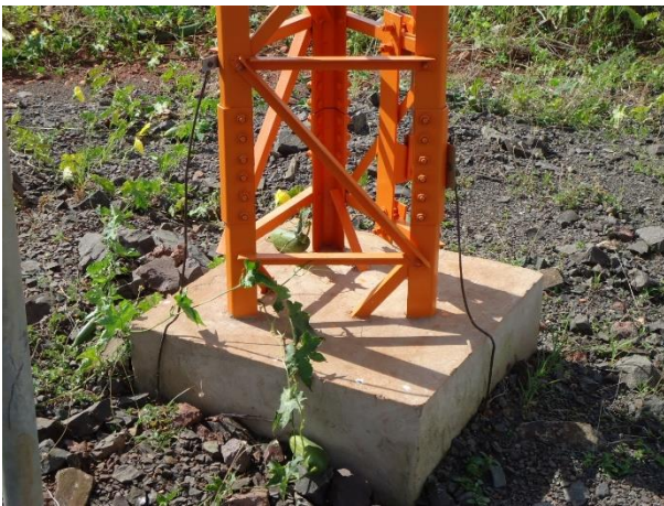
Aterramento do “pé” da torre.
