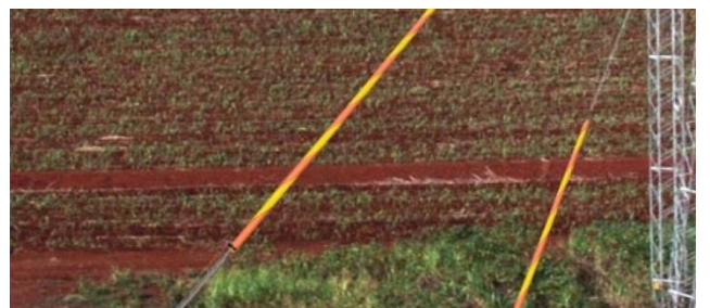
Cabos dos estais com sinalização.
