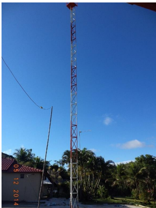
Torre tipo autoportante de formato reto.
