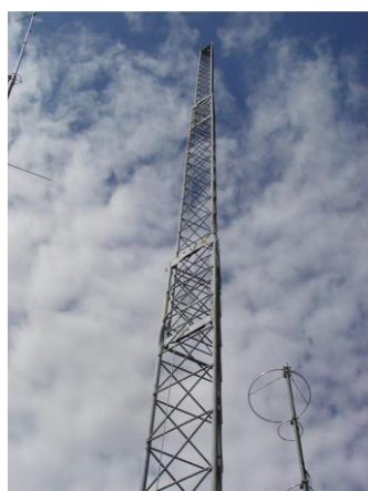
Torre telescópica já erguida.
