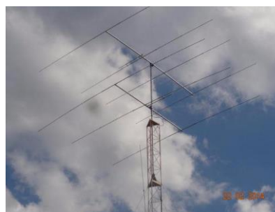
Torre com duas antenas tipo Yagi
