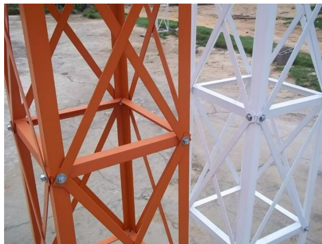
Torre quadrangular com elementos aparafusados.
