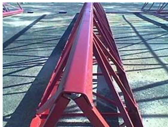
Torre construída com montantes de chapas dobradas e cantoneiras.
