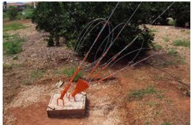
Bloco de ancoragem.
