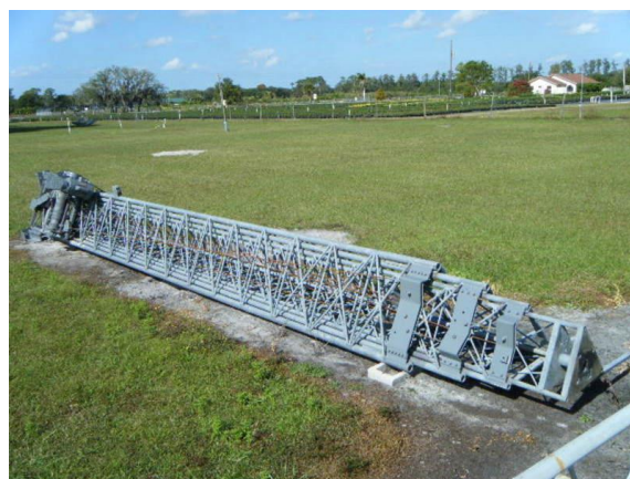
Torre telescópica sendo montada.
