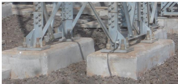
Aterramento do “pé” da torre.
